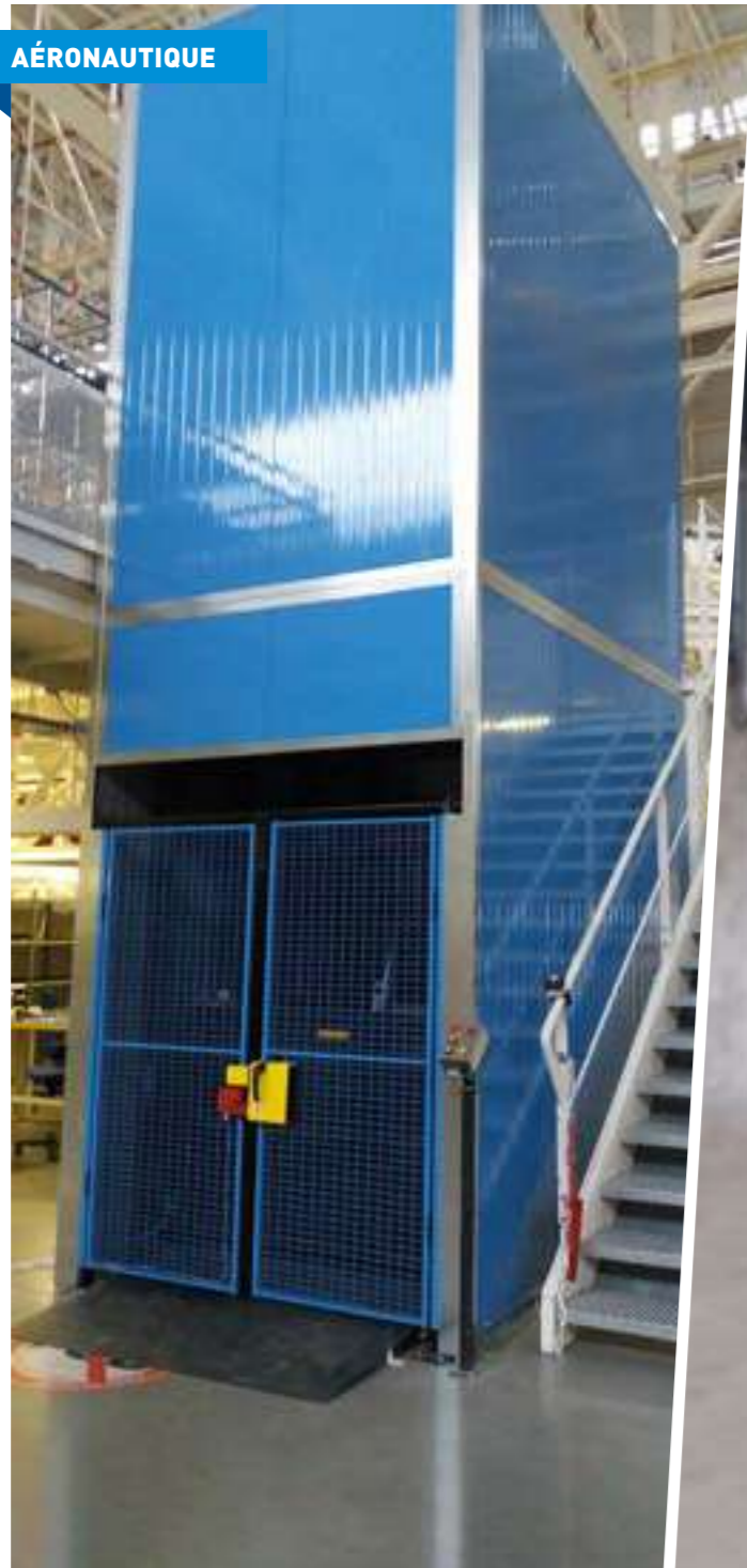
Monte-charge pour le transfert de chariots
