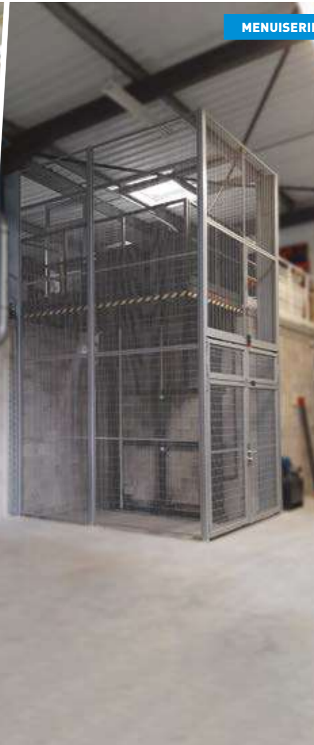
Monte-charge à colonne murale pour palettes
