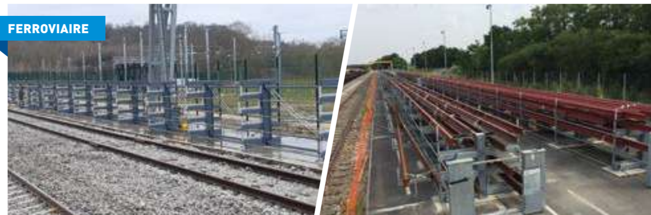
Stockage de rails
