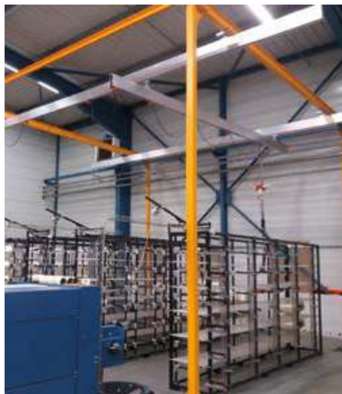
PORTIQUE ET POUTRE ROULANTE
